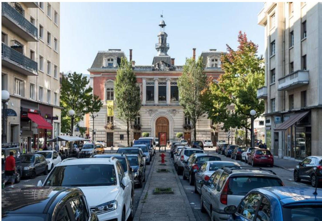
Avenue Général de Gaulle avant les travaux. ©Didier Gourbin/Ville de Chambéry
