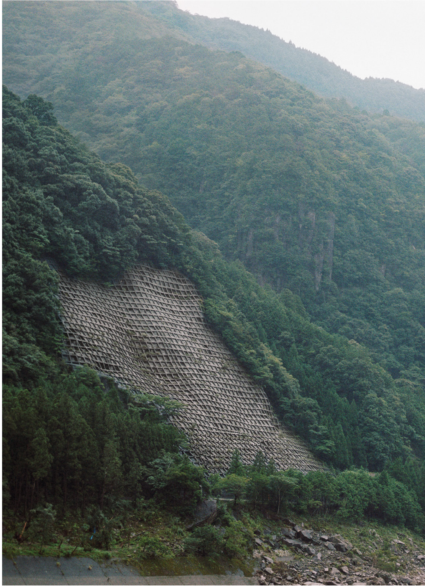
↓ Photo Julien Guinand, Ouvrage sabō le long de la rivière Kumano, 2015
