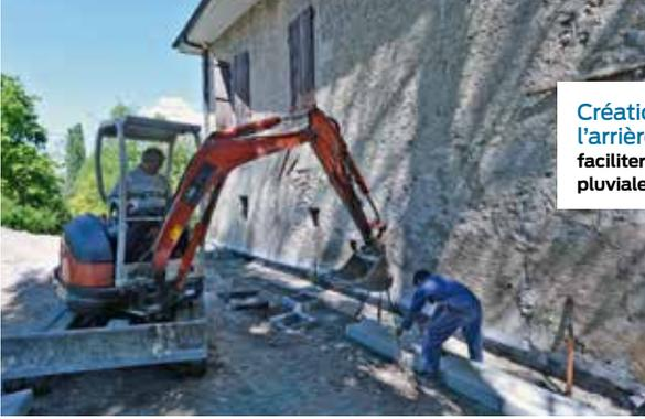
Création d'une rigole à l'arrière de la maison pour faciliter l'écoulement des eaux pluviales et assainir les murs.
