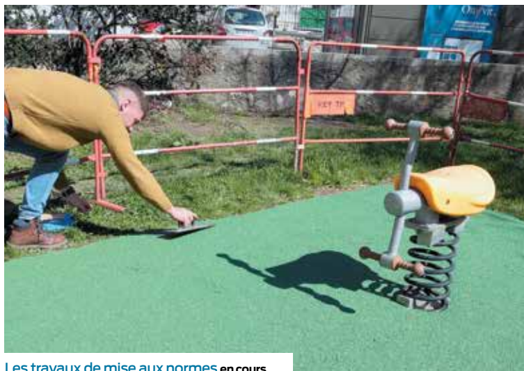
Les travaux de mise aux normes en cours.
