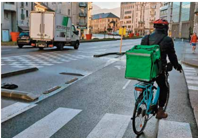
... et après les travaux.
