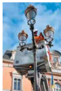
Changement d'une ampoule par une LED sur un lampadaire, place de l'Hôtel-de-Ville.
