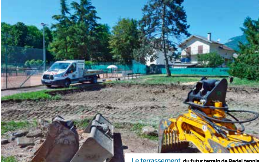
Le terrassement du futur terrain de Padel tennis.
