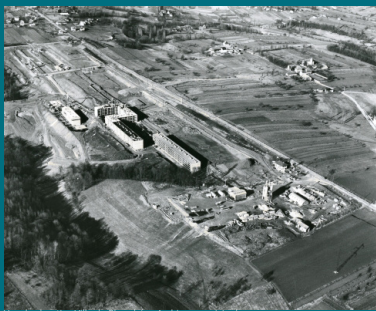
Vue de chantier, Ville de Chambéry, Archives municipales
