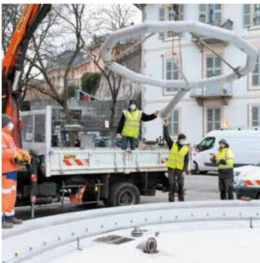
**LES COURONNES DE JET D'EAU** (d'ajutage) ont été entièrement déposées pour être détartrées. Ici, Place Caffé.
