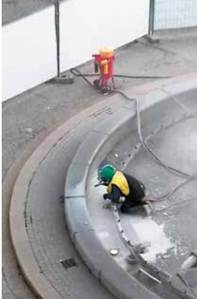
**LE CHANTIER CONSISTE EN UNE PHASE DE SABLAGE** par aéro-gommage de toutes les surfaces hors d'eau du bassin suivi d'une phase de reprise de l'étanchéité par l'application de 7 couches de différents matériaux résineux. Ici, le bassin central du Verney.
