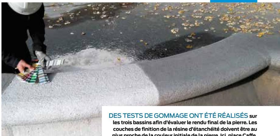
**DES TESTS DE GOMMAGE ONT ÉTÉ RÉALISÉS** sur les trois bassins afin d'évaluer le rendu final de la pierre. Les couches de finition de la résine d'étanchéité doivent être au plus proche de la couleur initiale de la pierre. Ici, place Caffé.
