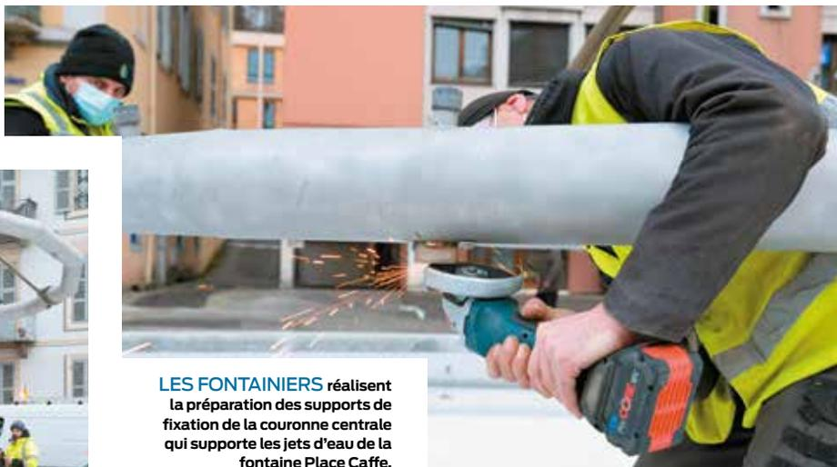
**LES FONTAINIERS** réalisent la préparation des supports de fixation de la couronne centrale qui supporte les jets d'eau de la fontaine Place Caffé.
