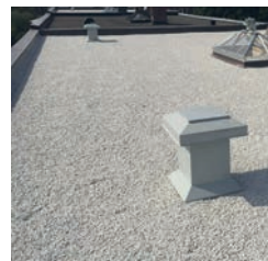
Toit terrasse graviers blancs Albédo : 0,70 IRS : 65
