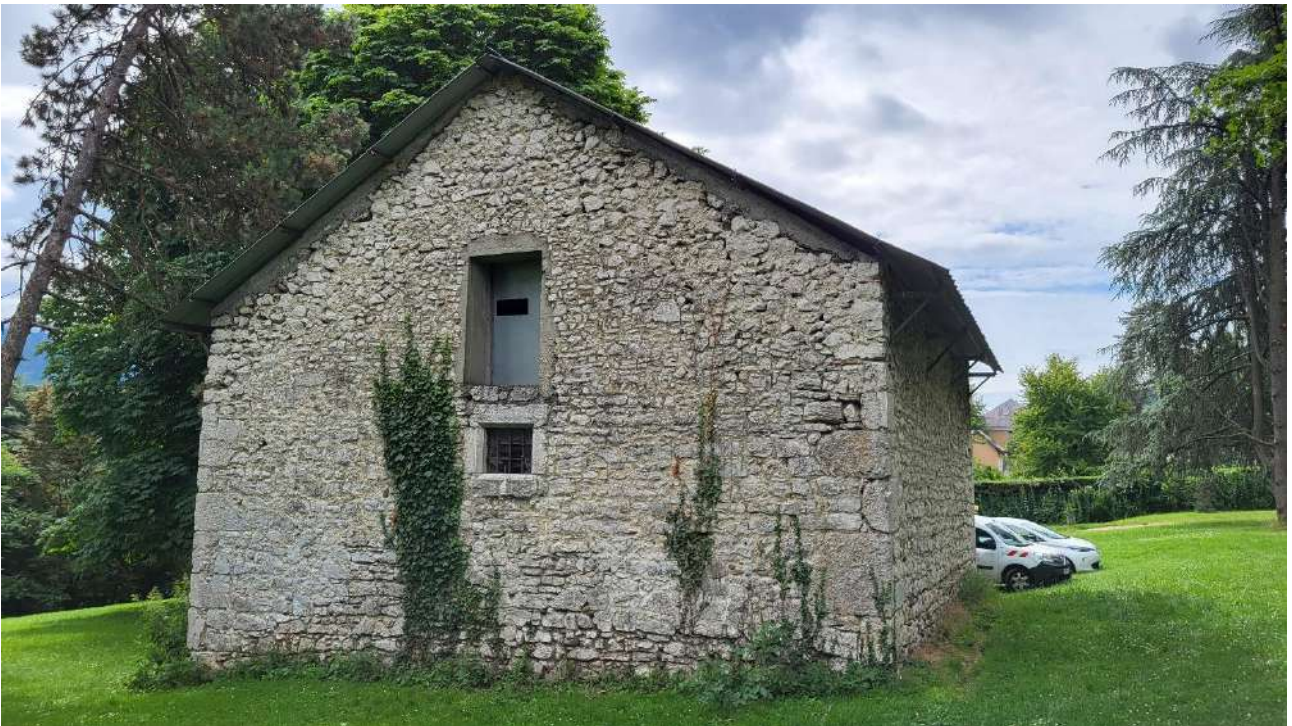
Bâtiment en pierre au parc de Buisson Rond prospecté dans le cadre de l'inventaire (© Ilan Badaoui-Finet).
