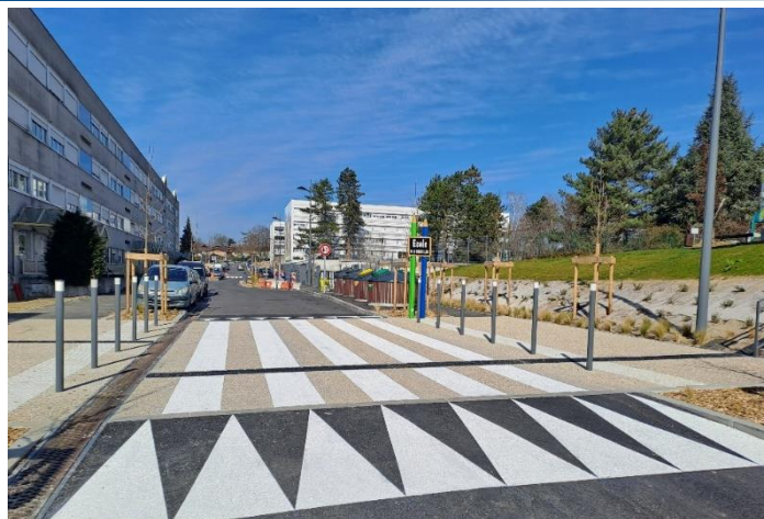
Plateau traversée piétonne
