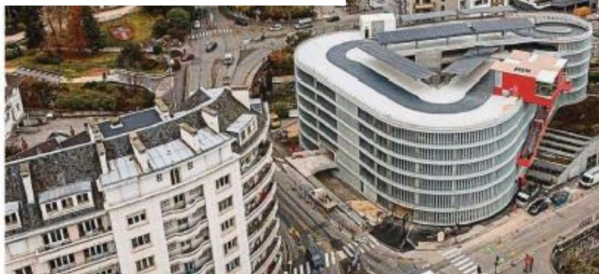
A l'issue de sa nouvelle acquisition, Q-Park comptera 400 sites en exploitation en France et près de 300.000 places de stationnement, dont la moitié en voirie. Photo Q-Park
