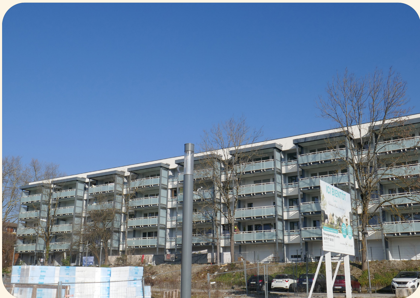
Résidence Les Granges – Rajouts de balcons
