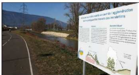
Le Cisalb expliquera le chantier de protection contre les crues sur la Leyse et sa renaturation à la fois in situ le long de la piste cyclable, départ du parking de la Boisse (Bissy), et sur un stand dans le village des sciences à Curial samedi et dimanche entre 10 h et 18 h. Document Agglo
