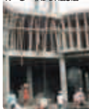
Quelques noeuds suffisent pour monter et démonter cet échafaudage complexe.
