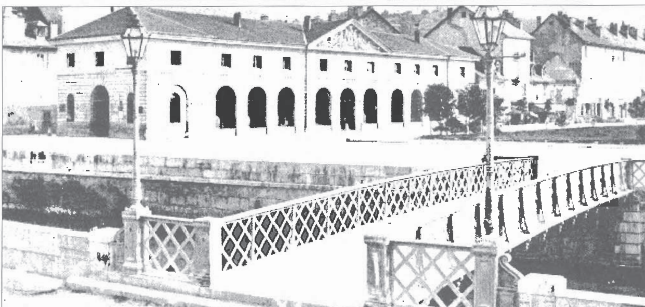
La nouvelle gare, les bords de la Leysse et la passerelle du Palais de Justice
