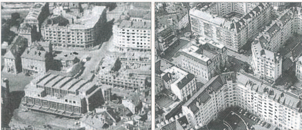
La Reconstruction en cours
