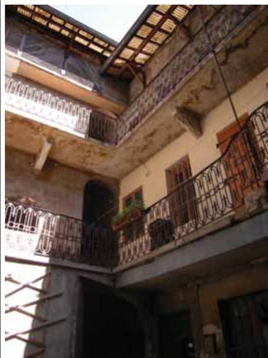
*Balcons rue d'Italie. Le balcon inférieur a été dénaturé par un socle en béton.*
