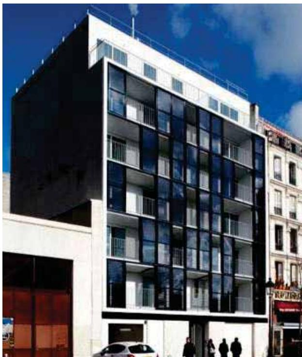
Agence Filippo- Kalt : immeuble de logements, Paris, avec vitrage isolant +capteur thermique (ECS) en façade
