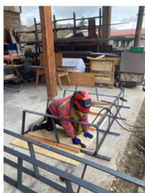
Février 2026 Préfabrication en atelier par les architectes-constructeurs
