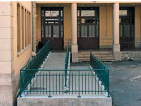
Une rampe d'accès a été installée à la Maison des Associations.
