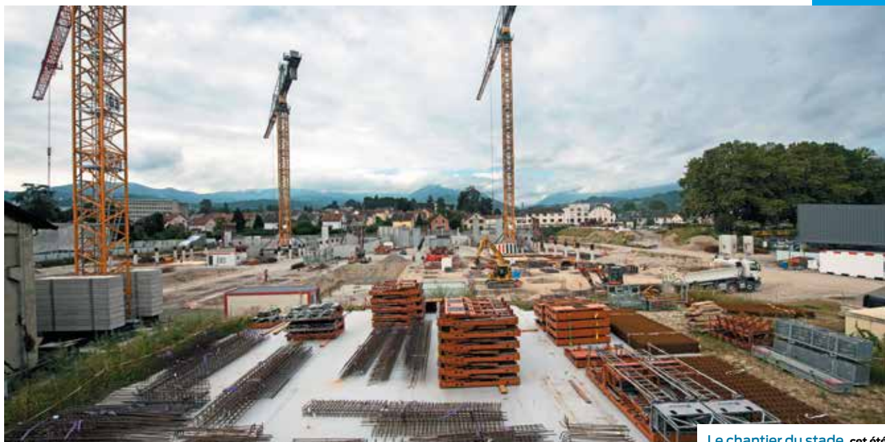
Le chantier du stade, cet été.
