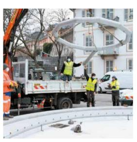
LES COURONNES DE JET D'EAU (d'ajutage) ont été entièrement déposées pour être détartrées. Ici, Place Caffe.
