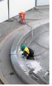
LE CHANTIER CONSISTE EN UNE PHASE DE SABLAGE par aéro-gommage de toutes les surfaces hors d'eau du bassin suivi d'une phase de reprise de l'étanchéité par l'application de 7 couches de différents matériaux résineux. Ici, le bassin central du Verney.
