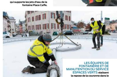
LES FONTAINIERS réalisent la préparation des supports de fixation de la couronne centrale
