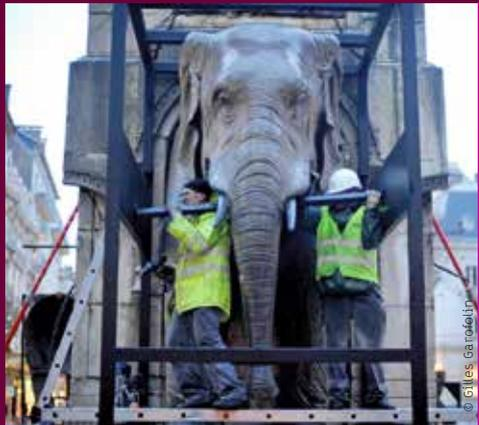
Pour chaque éléphant, une grille a été ajustée sur mesure. Le déboulonnage de la structure s'est effectué de l'intérieur en accédant via une trappe au sol au système de fontainerie. L'éléphant a été encerclé par la grille puis harnaché.
