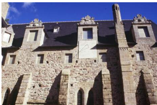
La restauration de l'abbaye de Beauport (Côte d'Armor) inclut un volet biodiversité. De nombreuses cavités nichoir ont été réservées dans les murs, les combles sont aménagés de façon à accueillir de nombreuses espèces : les nichoirs à martinets sont invisibles depuis l'extérieur, un nichoir à effraie des clochers a été placé dans les combles avec une discrète ouverture sur l'extérieur, de nombreuses ouvertures dans la toiture servent de lieu de passage aux chauve-souris.
