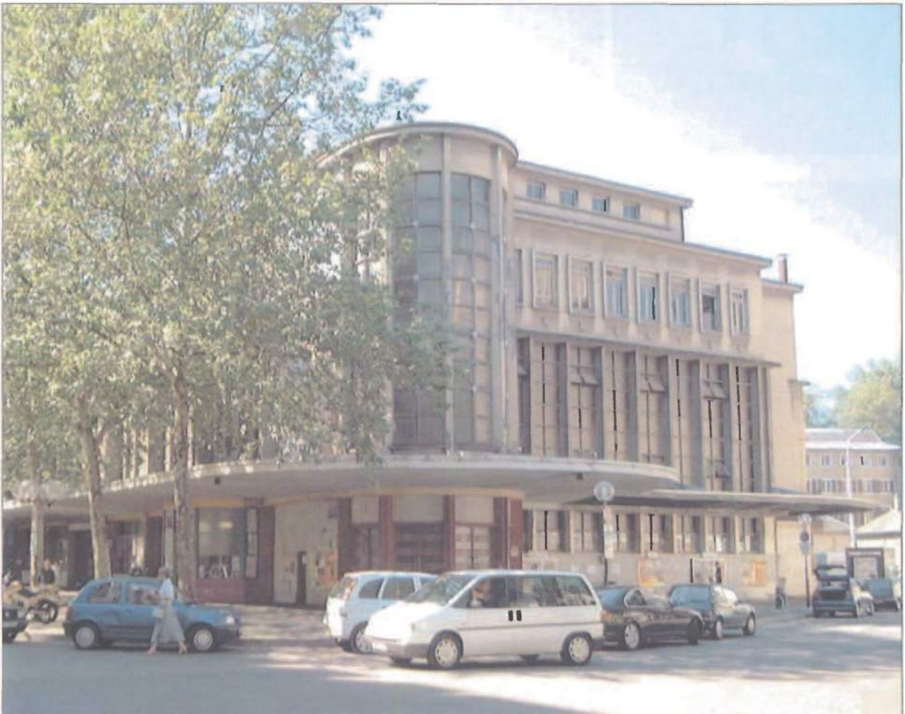
La halle des frères Bourdeix avant sa restructuration
