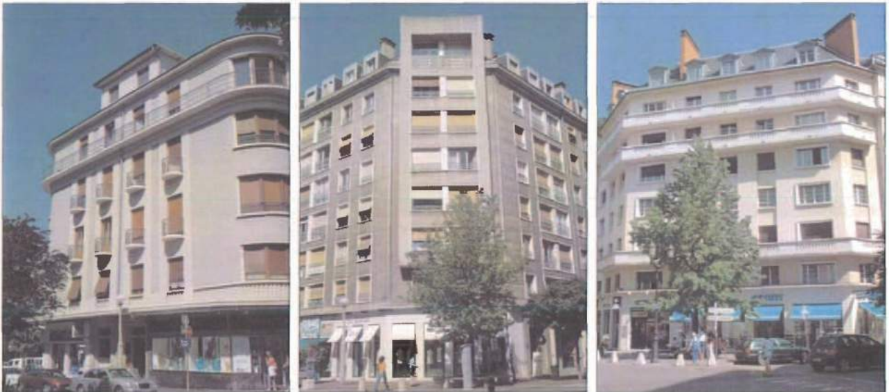
Les immeubles divers de la Reconstruction
