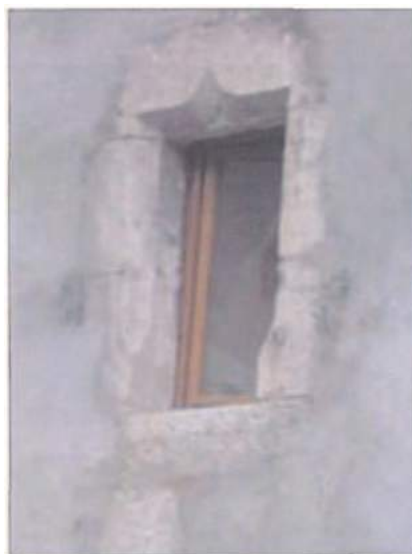
Fenêtre en «accolade» du 16 e siècle à la plaine de la Cassine
