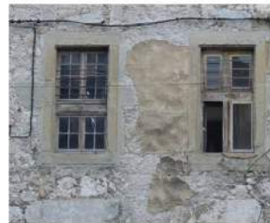
Élément parasite : ventouse de chaudière
