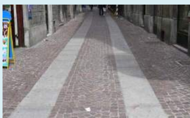
Pavés de Porphyre pour l'ensemble de la rue et dalle de pierre pour les bandes de roulement (Chieri, Italie)
