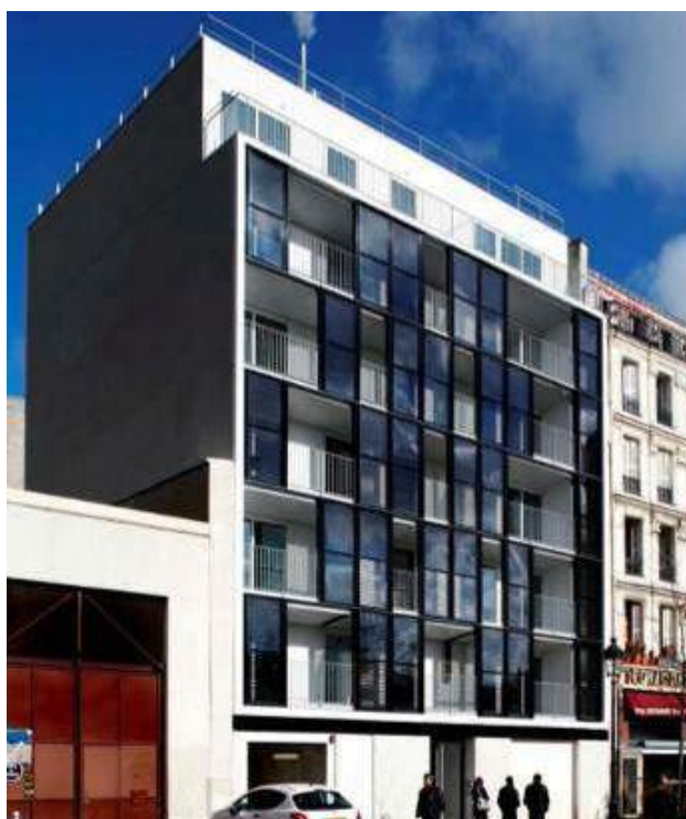
Agence Philippo- Kalt : immeuble de logements, Paris, avec vitrage isolant + capteur thermique (ECS) en façade
