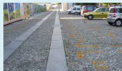
Calade pour l'ensemble de la rue et dalles de granit pour les bandes de roulement (Turin, Italie)
