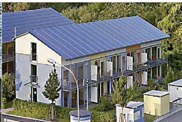
Panneaux photovoltaïques sur la totalité d'un versant
