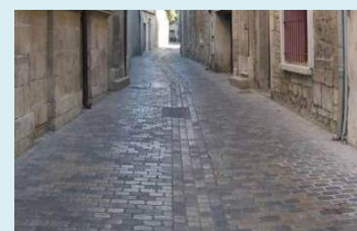
Pavés rejointoyés avec caniveau central
