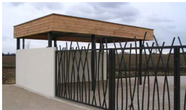
Garage à vélos aménagé pour la biodiversité Toiture végétalisée, pose de nichoirs
