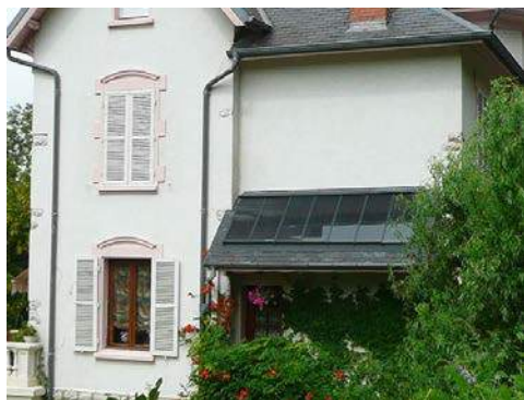
Intégration en annexe, sur un auvent Couverture ardoise avec panneaux photovoltaïques
