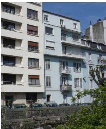
Quai Charles Ravet, immeuble de gauche
