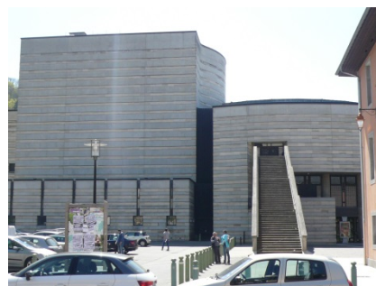
Espace Malraux Les architectures récentes de qualité (années 80)
