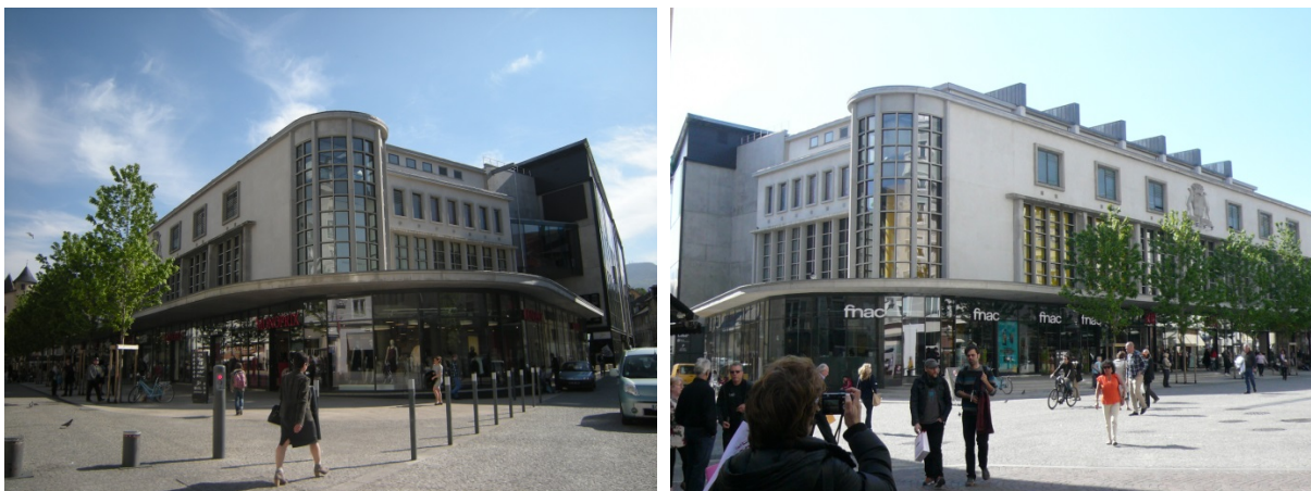
Les Halles, restauration et agrandissement
