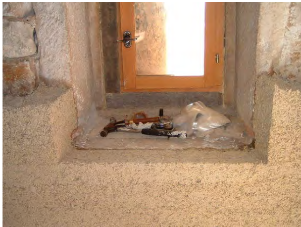
Enduit chanvre et chaux
