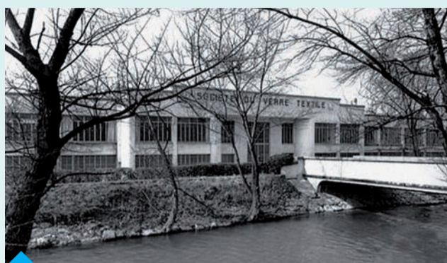
L'usine A au bord de la Leysse - © Photo Archives Saint-Gobain
